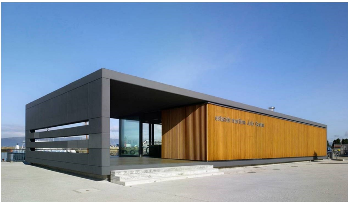
Revestimento em Madeira Termo-modificada e revestimento em alumínio do tipo Alucobond (fachada ventilada com isolamento térmico e acústico)
