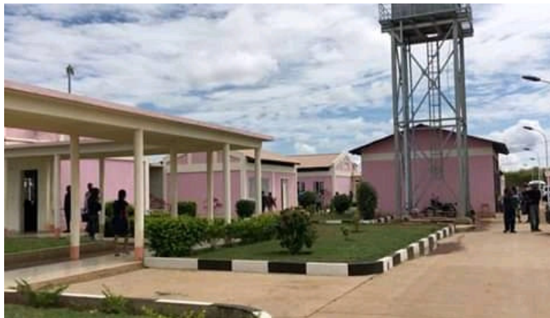
Fig. 2- Vista da parte interna da Escola Superior Politécnica de Malanje.
