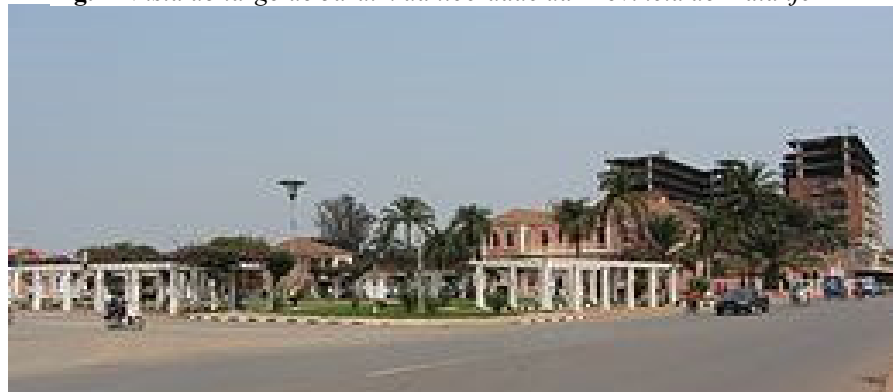
Fig. 1 -Vista do largo do Jardim da liberdade da Província de Malanje
