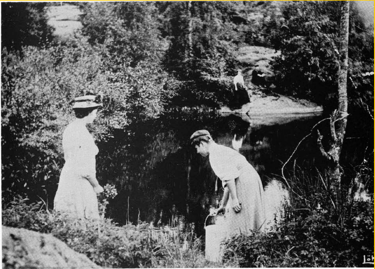
Vannhenting i Wergelandsdammen.
