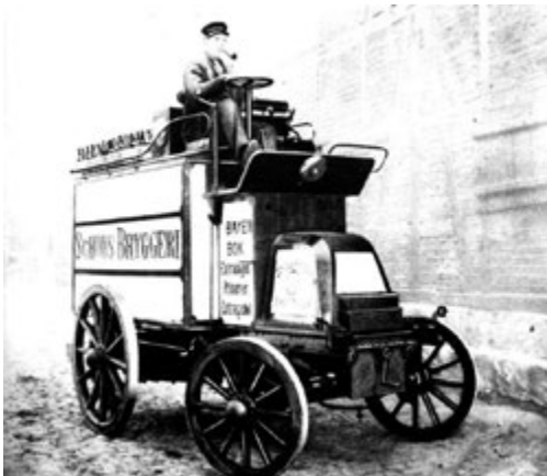
Norges første lastebil, en Daimler 1899-modell tilhørende Schous Bryggeri, trafikkerte Kristianias gater i 10 år. Vi ser at bilen har kompakte hjul og sveiv for oppstart av motoren. Vi merker oss også at bilen har høyre-ratt. Foto fra boka «På hjul i Norge»
