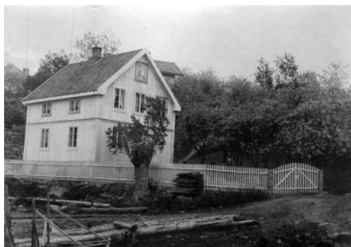
Bolighuset i Saltbukta etter ombygging i 1926. Foto utlånt av Gerd Oppedal.
