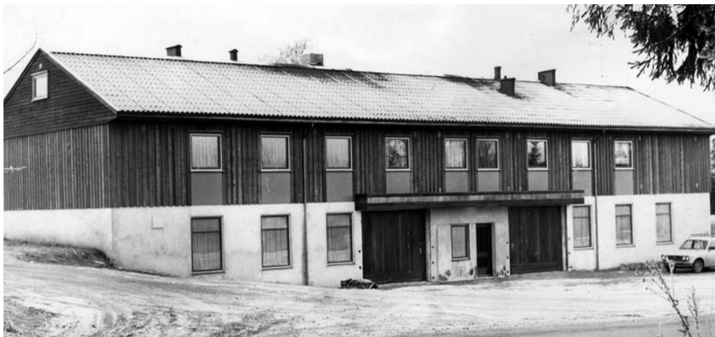
Det nye industribygget i 1972, sett fra Spikkestadveien. Foto utlånt av Egil Stokkerud.
