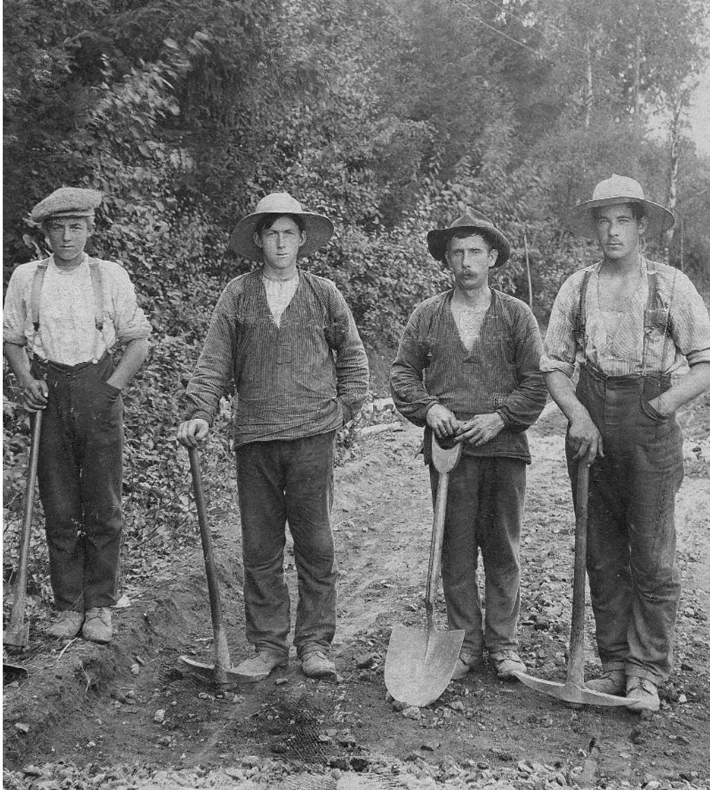
Disse tøffe karene bygger vei i Bødalen, sannsynligvis Aukeveien. Jobben ble trolig gjort under første verdenskrig.
