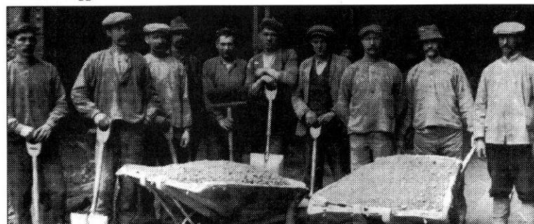
Klinker trilles fram til cementmøllene. Nr. 5 fra venstre: Johan Kristiansen. Helt til høyre formann Axe. Bildet er fra mellom 1925 og 1930.
