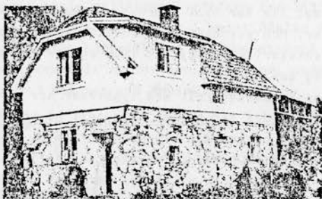
Det fredete steinhuset i Åros ser heller skrøpelig ut etter at murens er hugget av.
