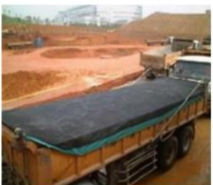
土石運輸車覆蓋防塵布
