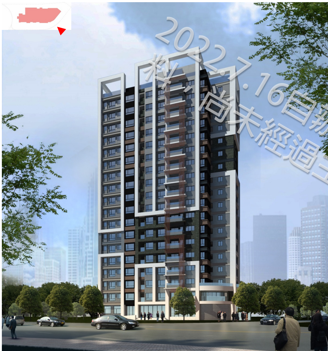
東向透視圖(面臨明德路)
