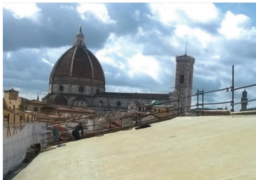
CONSOLIDAMENTO, ISOLAMENTO E IMPERMEABILIZZAZIONE CON RESINA ESPANSA ARMATA
