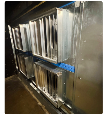
Shift #2 | Install New Fans
