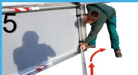
Pour la partie inférieure, soulever le soutien télescopique en agissant toujours de la base et ouvrir vers l'extérieur
