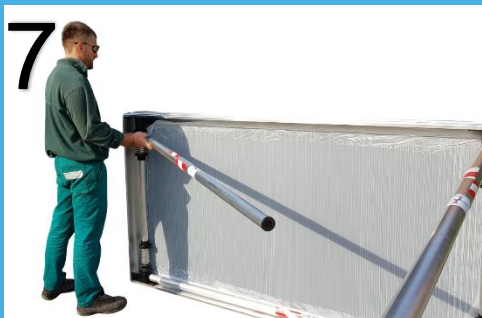
procéder avec l'ouverture des autres soutiens télescopiques
