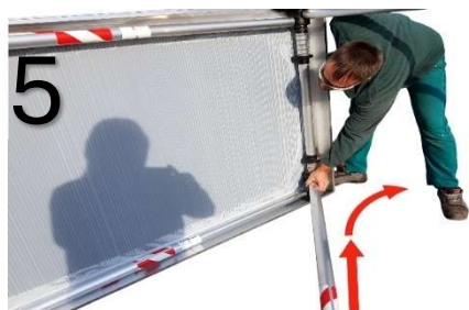
Per la parte inferiore sollevare il supporto sfilabile agendo sempre dalla base e aprire verso l'esterno
