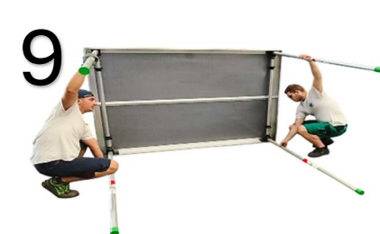
La regolazione dell'altezza del tunnel pedonale avviene tramite lo sfilo dei tubi telescopici che si possono regolare nella posizione come in figura o sollevato
