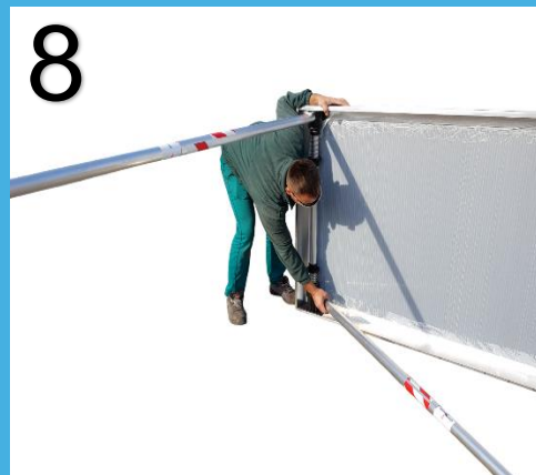
Per la parte inferiore sollevare il supporto sfilabile agendo sempre dalla base e aprire verso l'esterno
