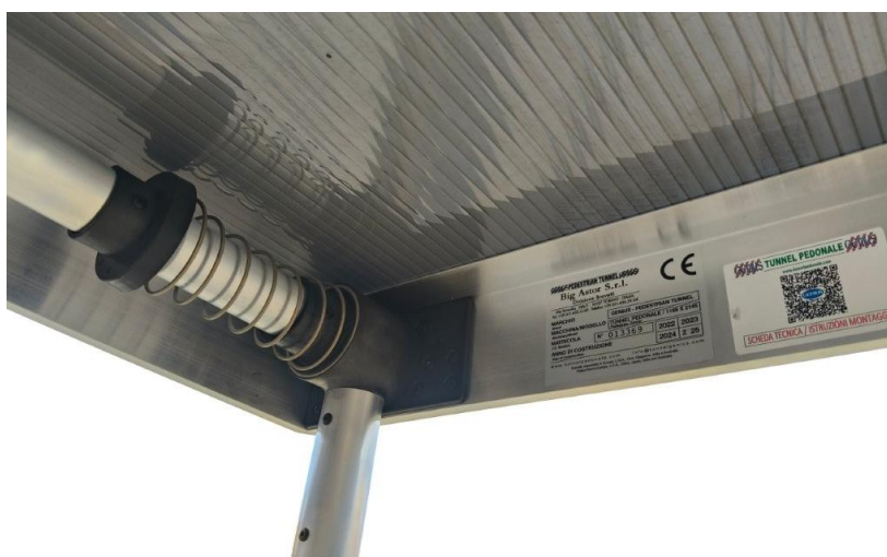
Targa di identificazione del tunnel pedonale posizionata correttamente
