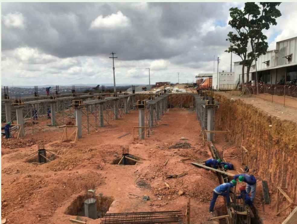
Início da obra Refeitório, em 2021.
