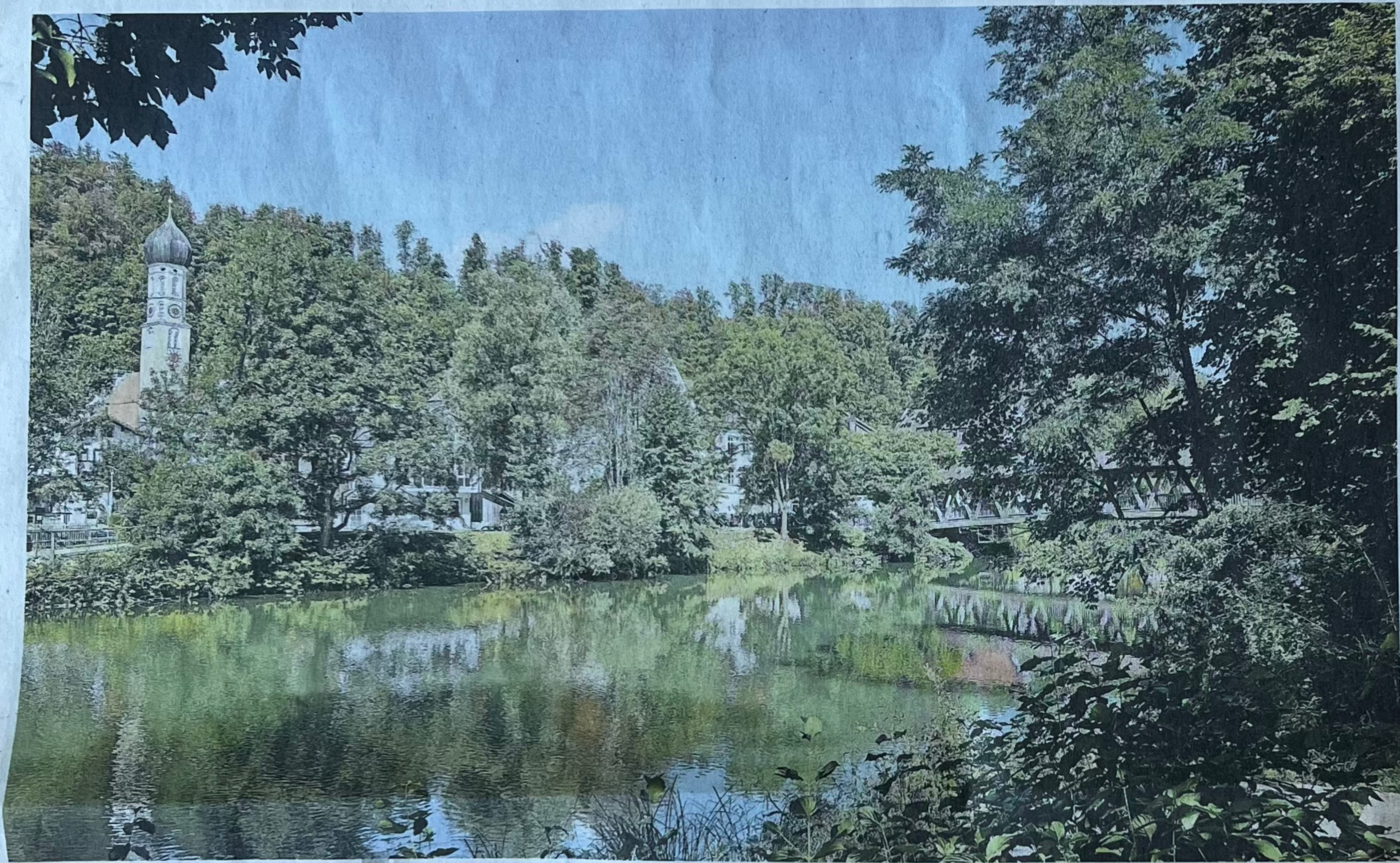
Zum Uferschutz sollen an der Wasserlinie der Loisach in Wolfratshausen um die 4500 Steine gesetzt werden.
