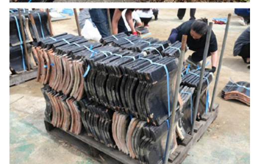
Processo di recupero delle tegole nere di Noto, curato da Voluntary Architects Network e Shigeru Ban Architects
