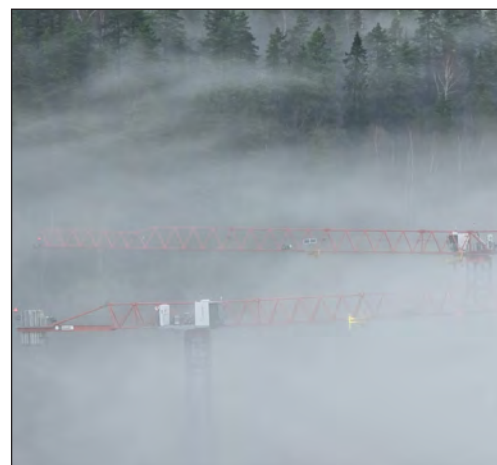
Kraner i tåkehavet over Heggedal Hage. Foto: Mona Solberg Westengen (3. november 2025)
