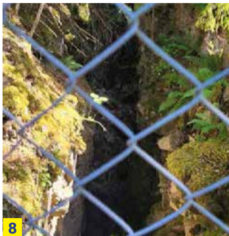
8 Den dype sjakten under broen.
