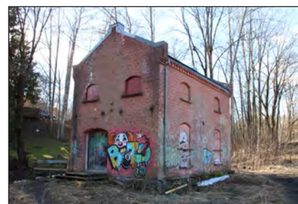
Ved Blakstad sykehus står restene etter kraftverket. Turbin og generator ble fjernet på 1970-tallet
