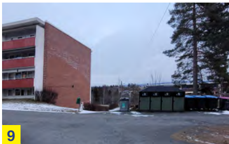
Mellom søppeldunkene og blokken går gangveien ned til stasjonen
