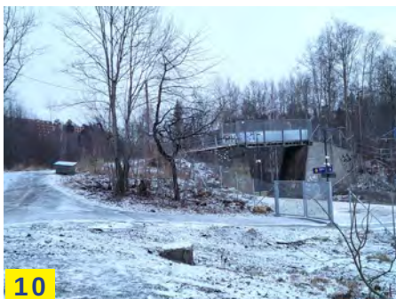
Brua over jernbanen ved Bondivatn Stasjon
