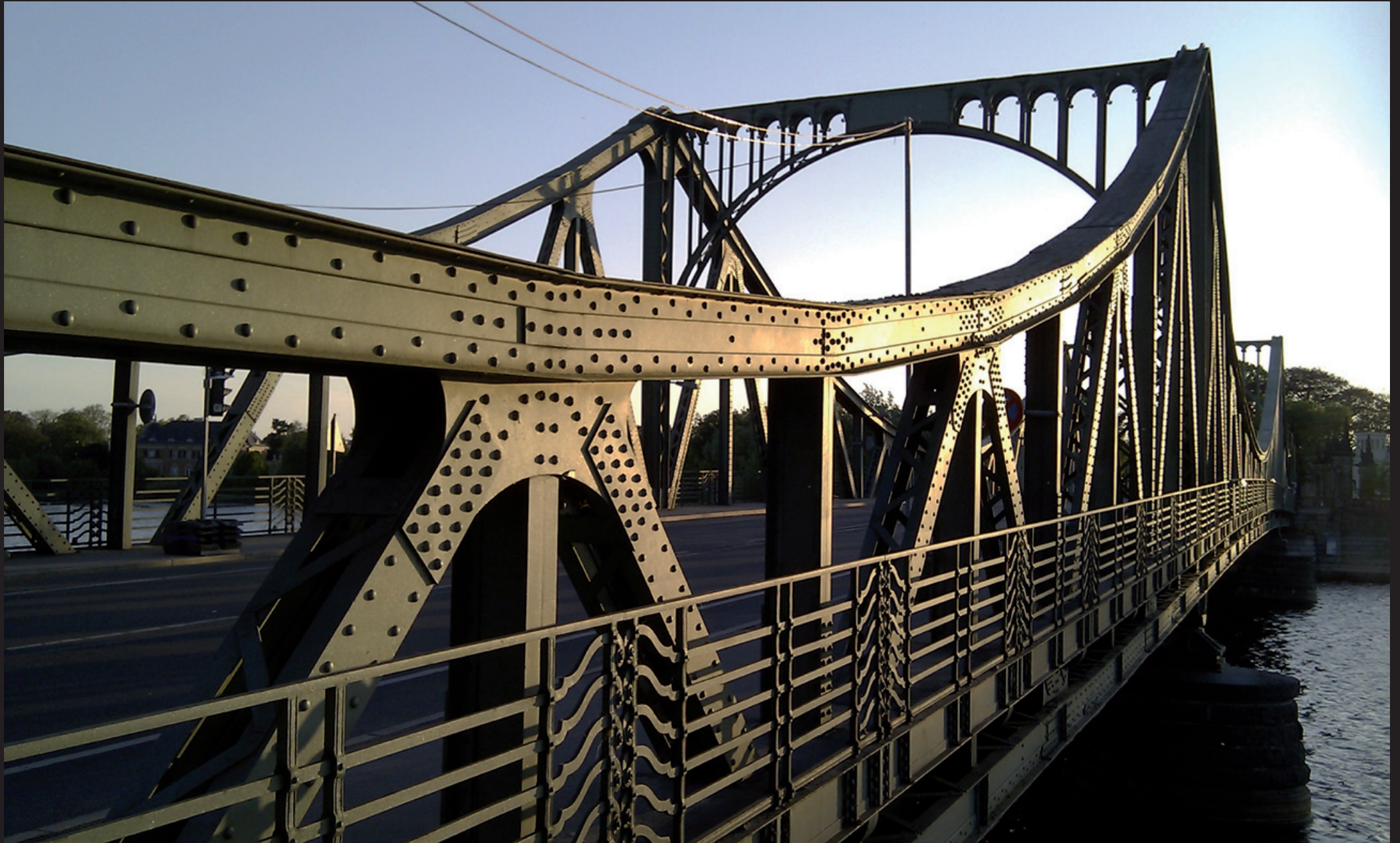
Brücke der Wiedervereinigung
