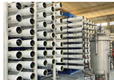
Recambio parcial de membranas estándar por Nano H_2O (ex LG-Chem) de alta eficiencia para osmosis inversa.
