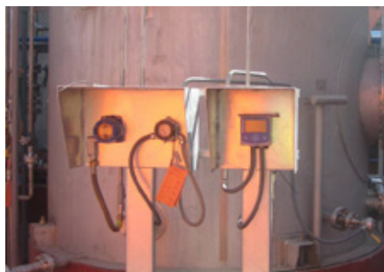
Sistema integrado de medición de variables analíticas Mettler Toledo en planta de recuperación de molibdeno.
