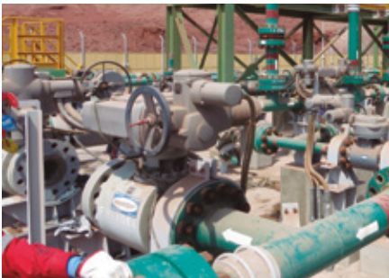
Conjunto válvula de bola ValvTechnologies para servicios severos y actuador inteligente Auma para líneas de concentrado de cobre.
