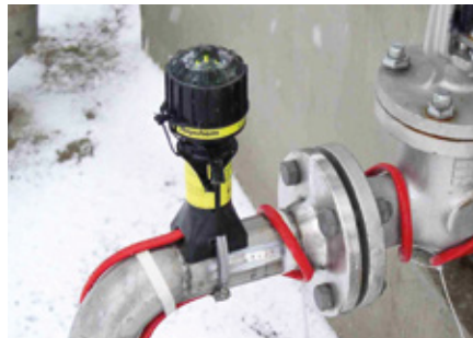
Raychem Heat Tracing, cable calefactor y solución anti-congelamiento para mantención de temperatura de fluidos.
