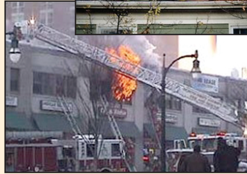
Daño por Fuego
