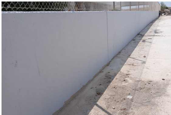
Cerramiento perimetral — muro bajo y valla metálica
