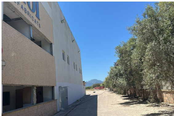
Fachada principal — cartel «FABRICATS» y olivar perimetral
