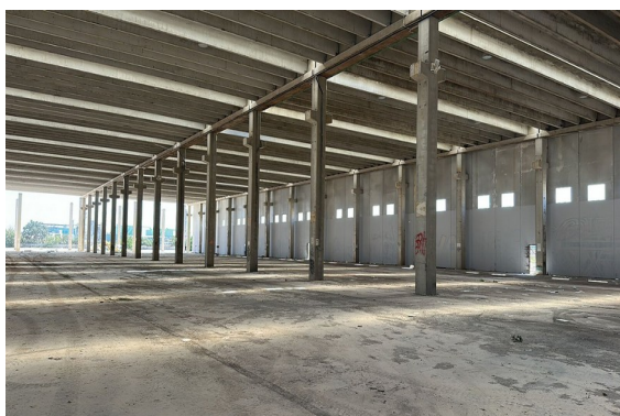
Estructura — pilares y vigas de hormigón armado
