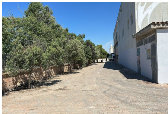
Vial empedrado — acceso perimetral al sur del inmueble
