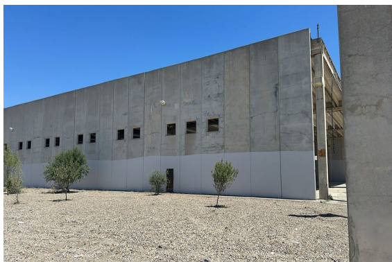
Fachada lateral — paneles prefabricados de hormigón
