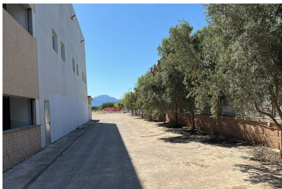
Vial perimetral pavimentado y alineación de olivos
