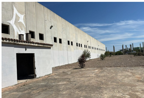
Fachada trasera — continuidad hacia parcela anexa (pórticos)
