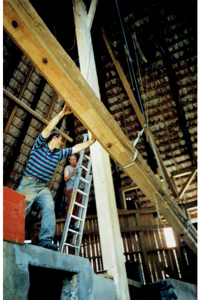
Diverse Umbauarbeiten im Läbihus
