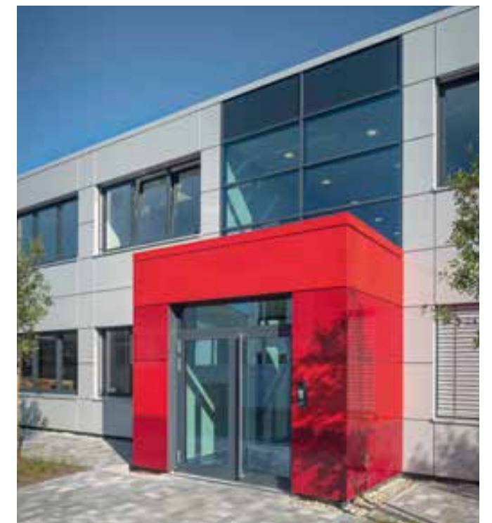
Bürogebäude, Eichenauer, Hatzenbühl
