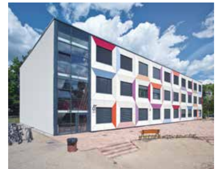
Das modulare Schulgebäude vor dem Anbau.
