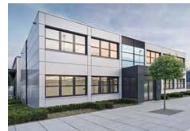
Das Bürogebäude vor der Aufstockung.
