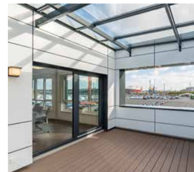
Dachterasse, Bürogebäude Heinrichs, Bremerhaven
