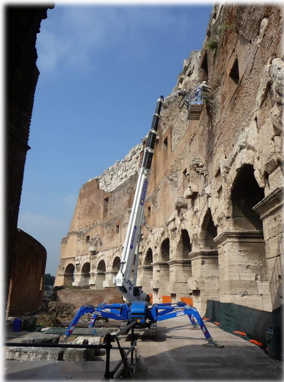
(Interventi di messa in sicurezza al Colosseo)
