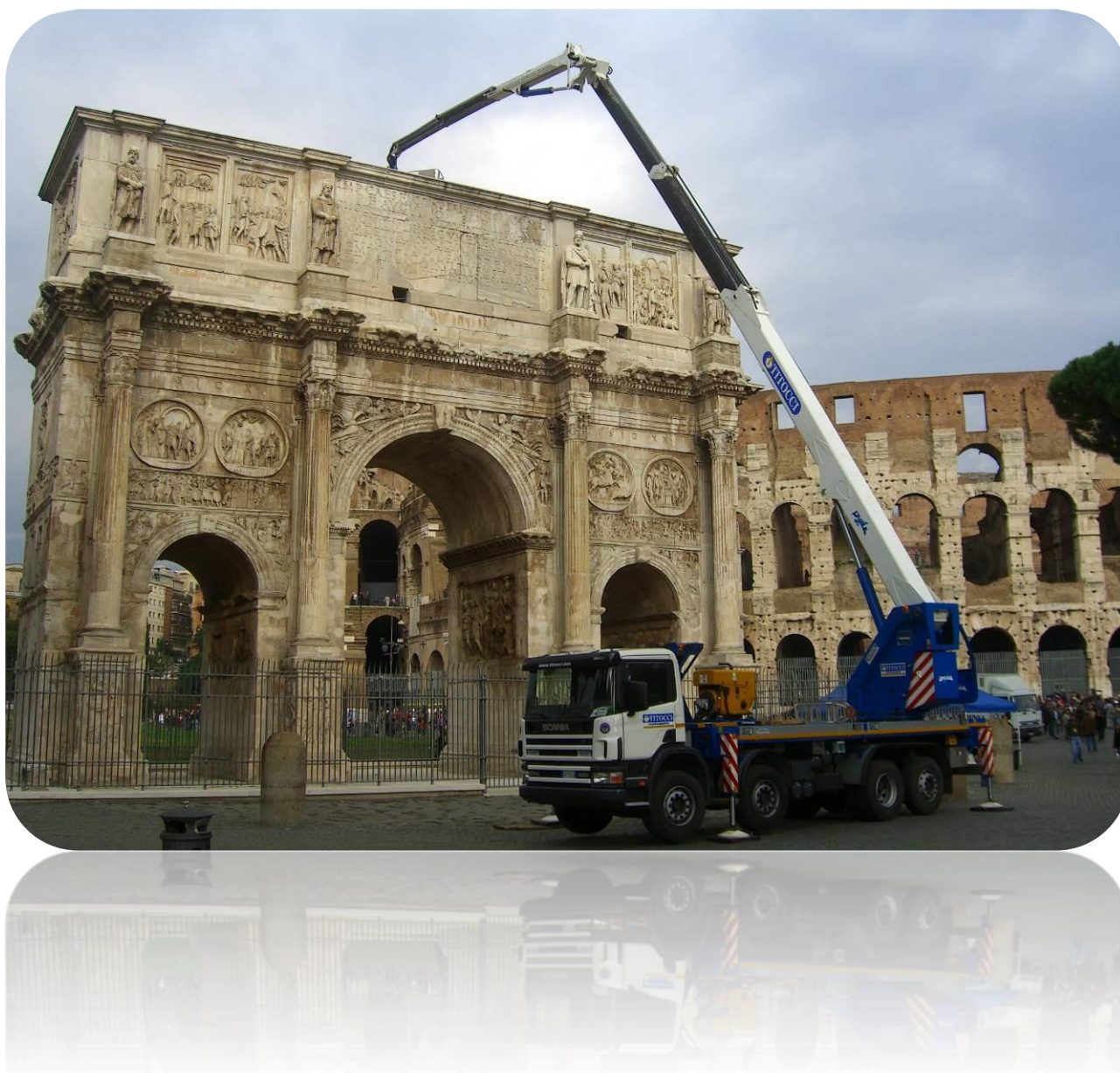
(Intervento di manutenzione presso l'Arco di Costantino)
