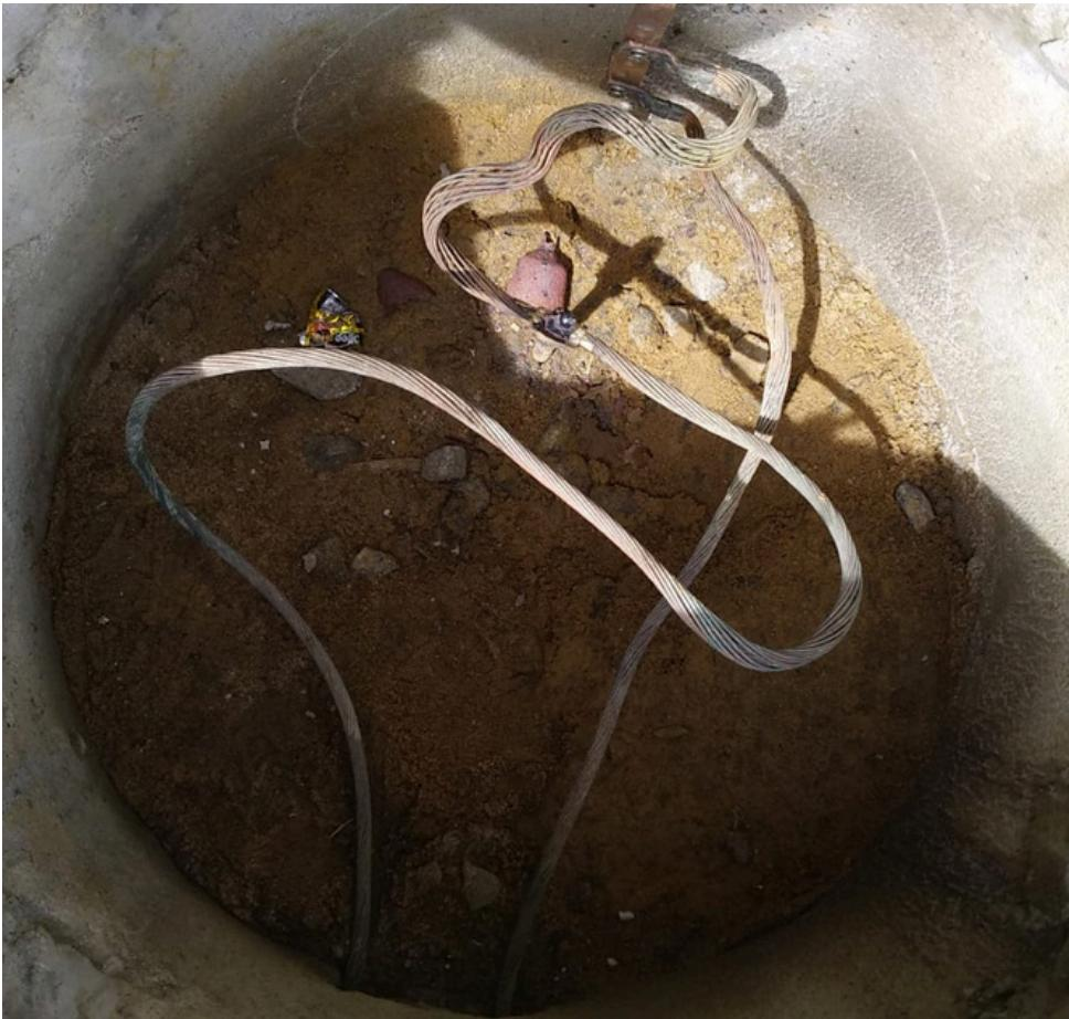
Os Sistemas de Proteção contra Descargas Atmosféricas são estruturas para captação e redirecionamento de raios, feitas através de descidas e malhas de aterramento contínuos com o menor valor de resistência possível, permitindo que a descarga elétrica seja descarregada no solo sem dificuldade.
