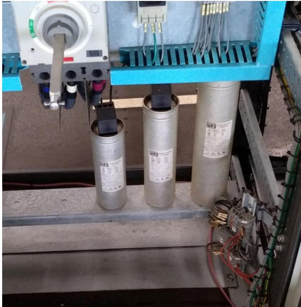
A correção de Fator de Potência está atrelada à eficiência energética, permitindo que a partir de uma avaliação do sistema elétrico de um estabelecimento por meio de uma análise de energia, consiga mitigar ou reduzir as multas por excesso de potência reativa (desperdício de energia) e aumentando a vida útil dos equipamentos e instalações.
