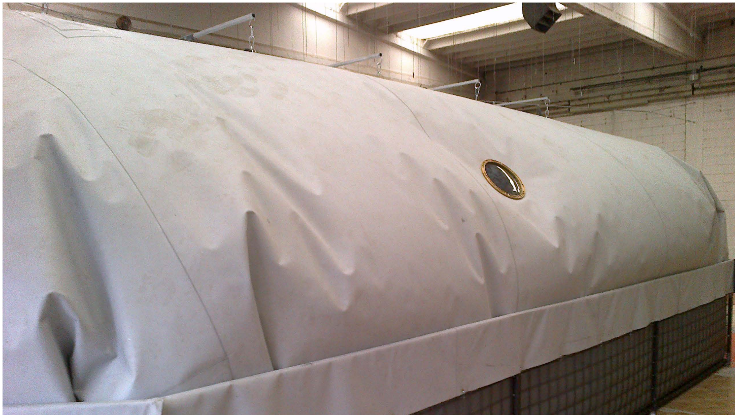
Realizzazione copertura impianto biogas (Piacenza)
