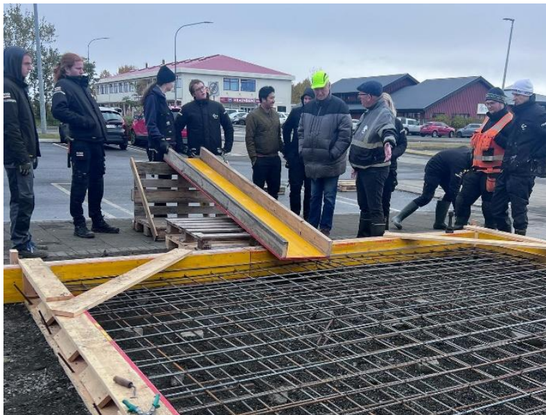
Nemendur og kennarar undirbúa og steypa plötu undir húsið.
