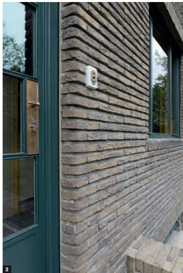
1 Een kroonlijst en balkon in sierbeton versterken de horizontaliteit. 2 De waterslagen liggen in het vlak van de gevel en zijn afgerond, net als de overige bakstenen rond de gevelopeningen.
