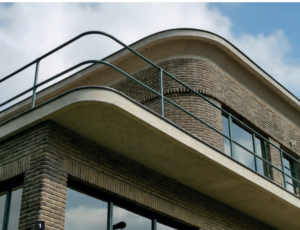
1 Een kroonlijst en balkon in sierbeton versterken de horizontaliteit. 2 De waterslagen liggen in het vlak van de gevel en zijn afgerond, net als de overige bakstenen rond de gevelopeningen.
