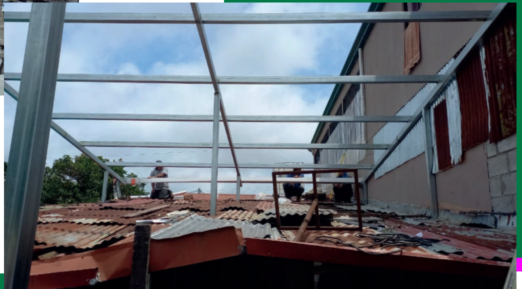
ESTRUCTURADO DEL NUEVO TECHO
