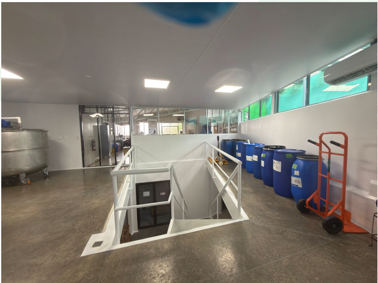
Construcción de nueva área para producción de cosméticos
