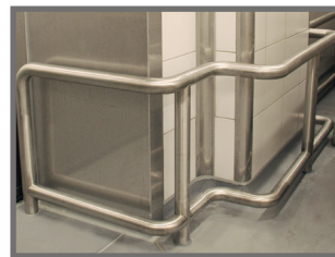
WKLEJANE W POSADZKĘ GLUED TO THE FLOOR
