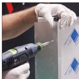
FISSAGGIO CORNICE ANGOLARE
