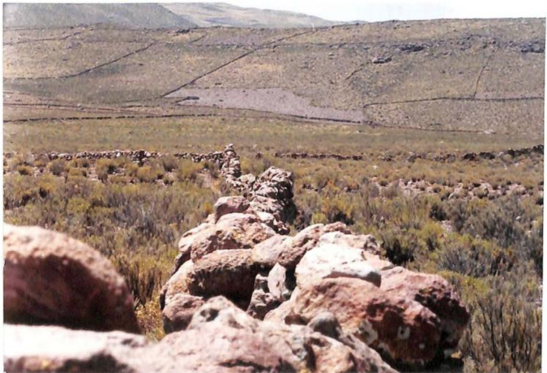
F.2 MURO CONTEMPORANEO DE DOBLE SECCION
