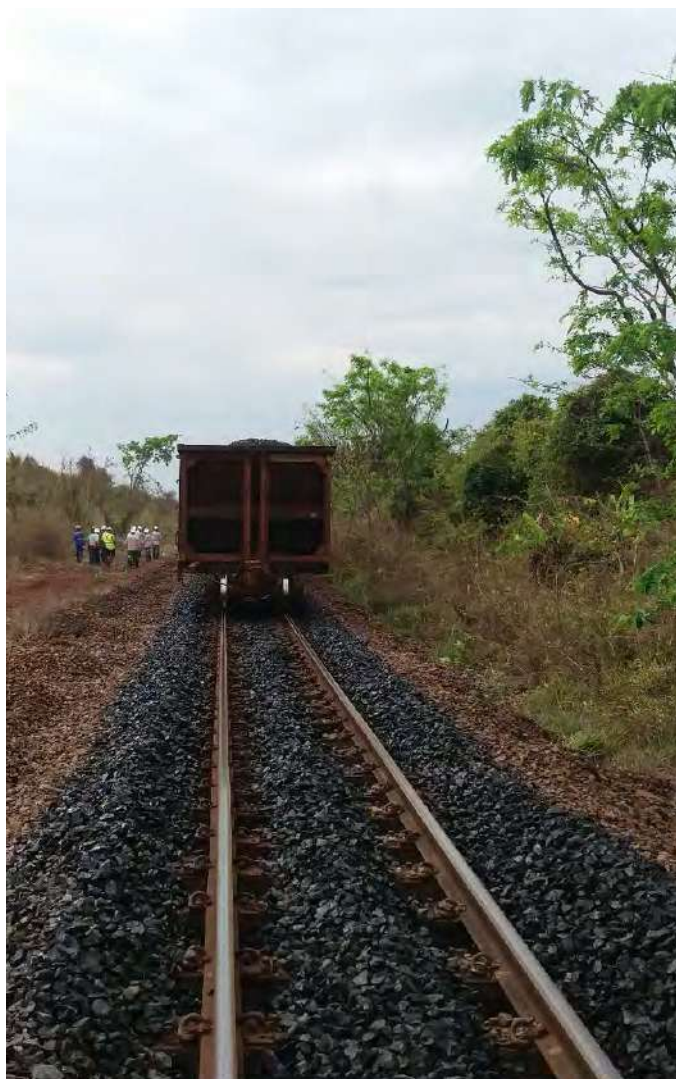
Descarga concluída, sem interferência nas fixações dos trilhos
