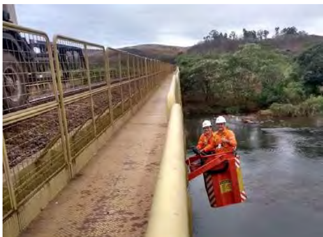
Equipe de Manutenção de Pontes em Inspeção
