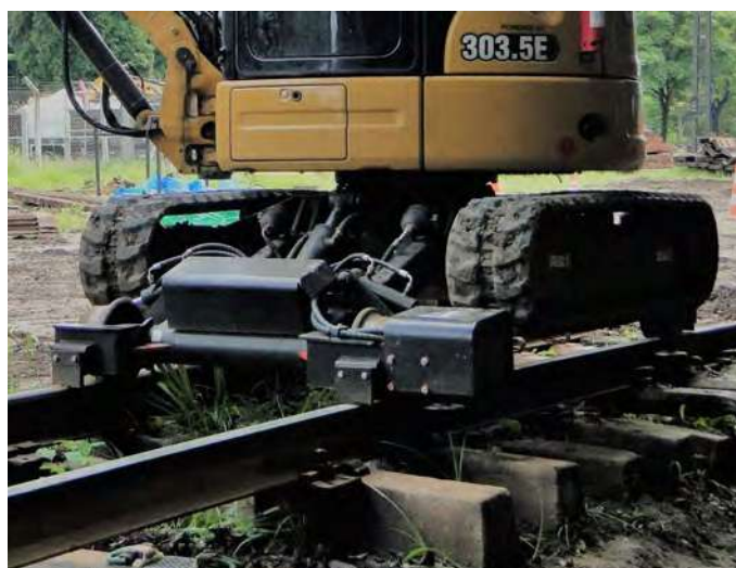
Mini Escavadeira com o kit ferroviário acionado.
