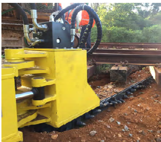
Sabre Desguarnecedor de Lastro em operação, visão inferior
