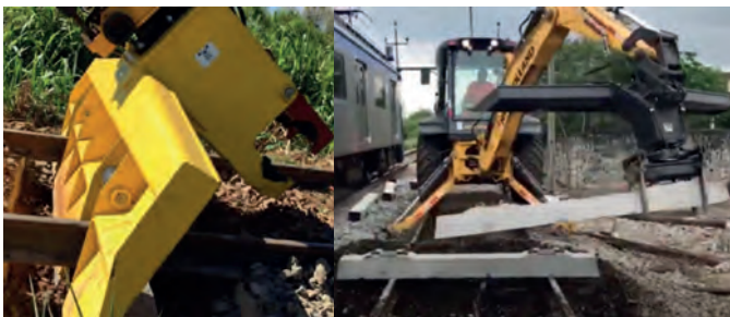
Implemento de Substituição de Dormentes com Abertura de Cavas no lastro
