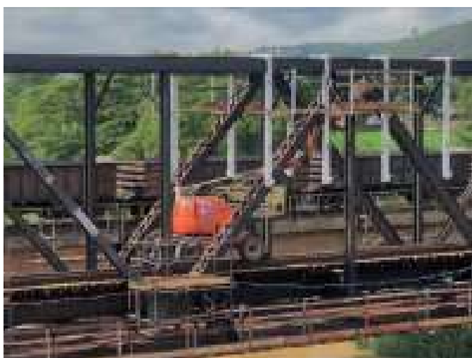
Equipe de manutenção realizando soldagem em ponte com plataforma rodferroviária
