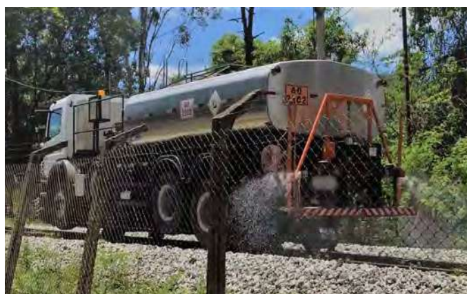
Visão do equipamento realizando aspersão
