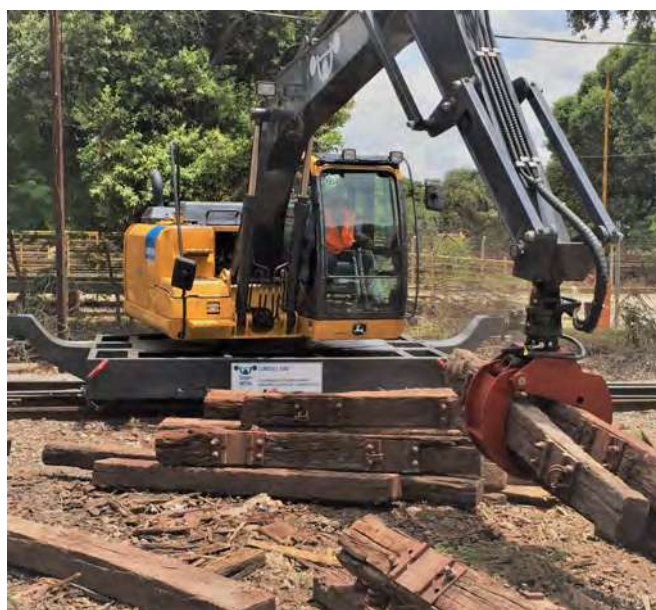
Visão lateral do Guindaste de Dormentes em operação
