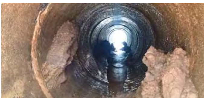
Bueiro desobstruído, findada a limpeza com hidrojateamento
