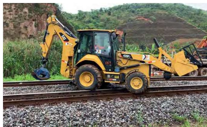
Retroescavadeira transpondo linha férrea em local de difícil acesso
