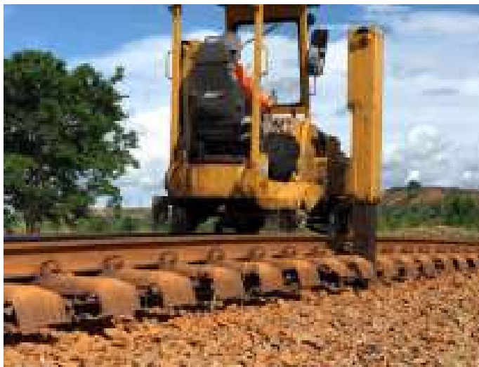
Veículo em acionamento da elevação da via
