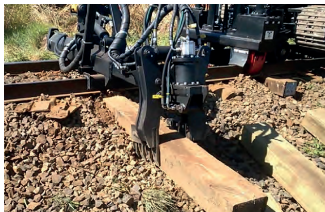
Implemento de Dormentes por Substituição Lateral
