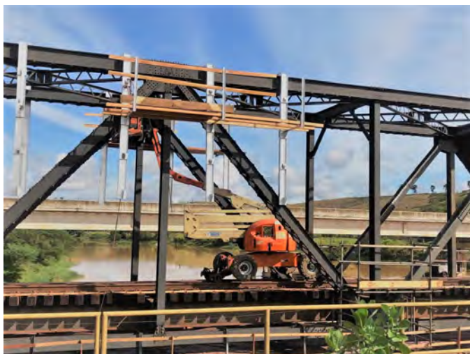
Plataforma elevatória rodferroviária em intervenção em ponte
