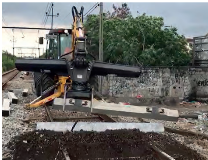
Demonstração do implemento utilizando a garra e movimentando dormentes
