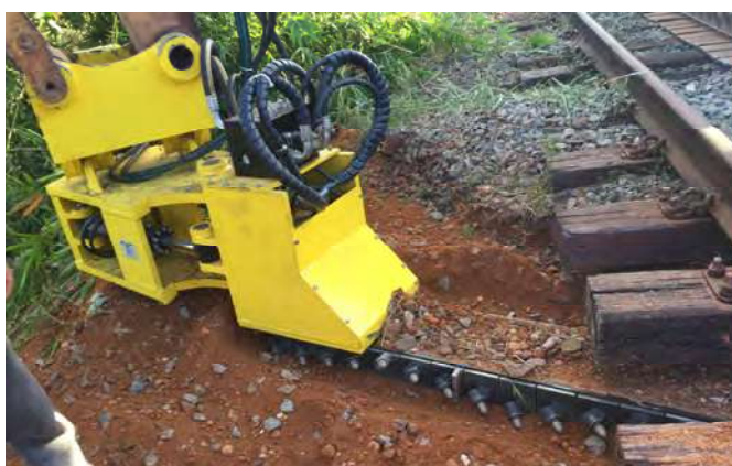
Sabre Desguarnecedor de Lastro em operação, visão lateral
