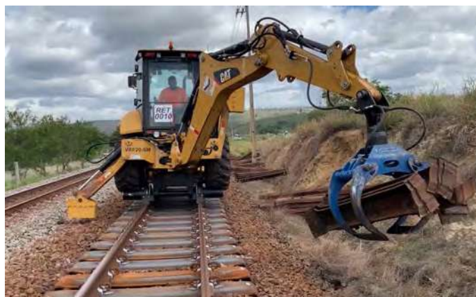
Retroescavadeira realizando movimentação de dormentes
