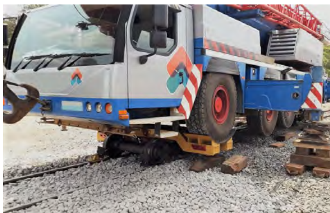
Equipamento acionando patolas para posicionamento dos Troles
