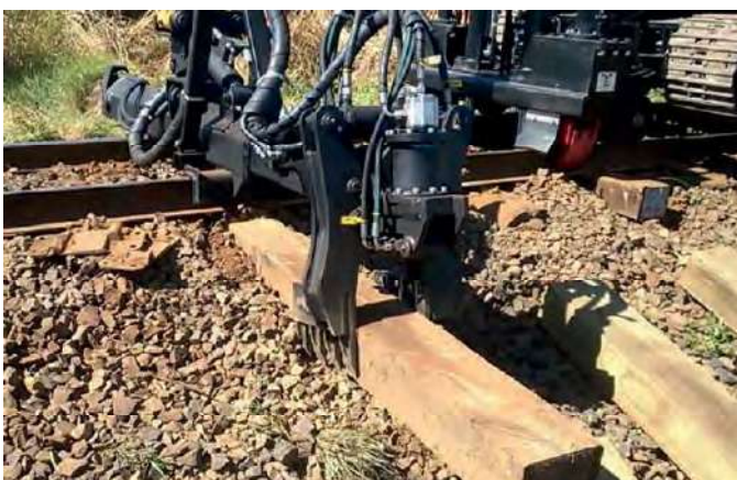
Implemento de Dormentes por Substituição Lateral
