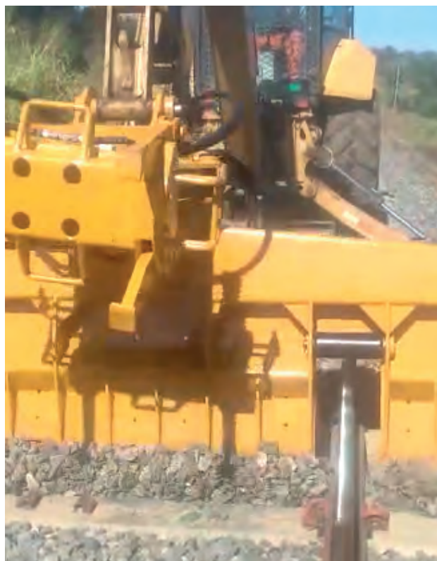
Movimentação de lastro com a pá do implemento
