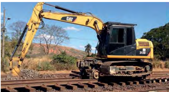
Escavadeira realizando serviço de infraestrutura
