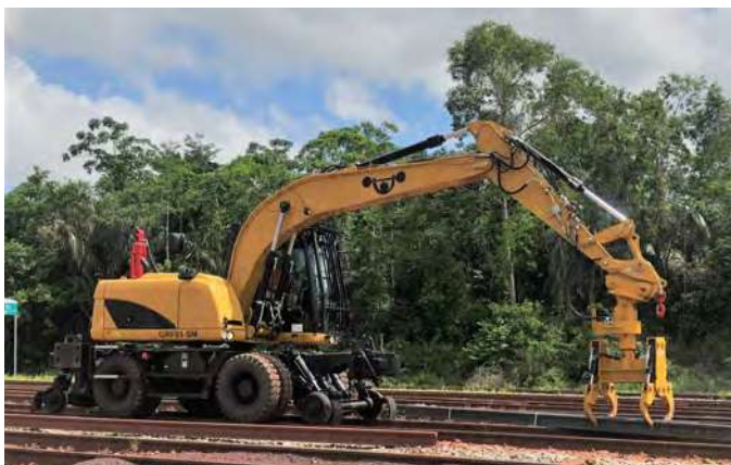
Guindaste Rodoferroviário movimentando componente de AMV
