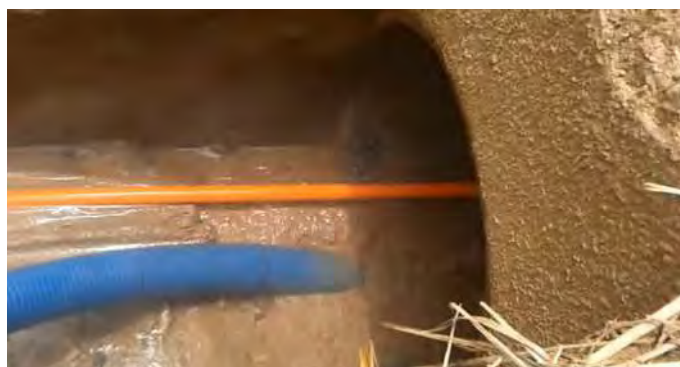
Mangueira laranja para Jateamento e azul para Sucção da água de volta para o tanque
