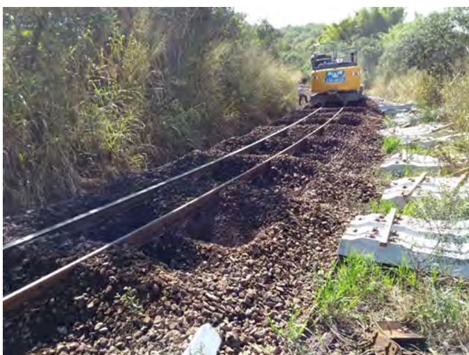
Aspecto da via após a passagem do equipamento escarificador
