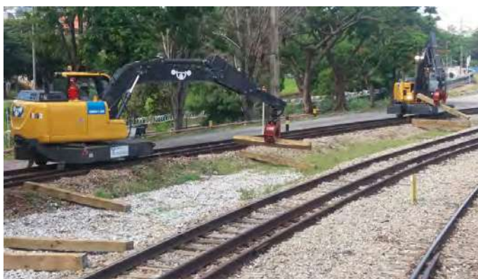
Guindastes realizando a movimentação de dormentes
