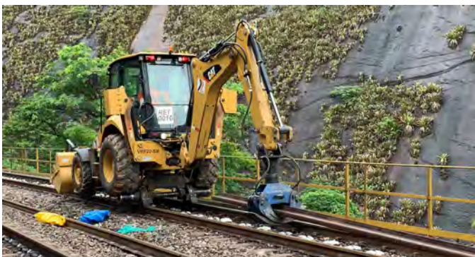
Retroescavadeira realizando movimentação de trilhos
