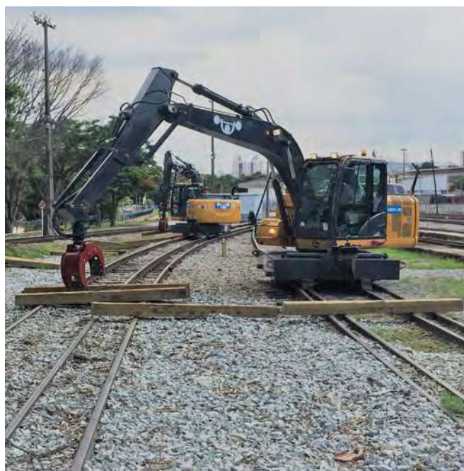
Equipamento realizando movimentação em linha adjacente
