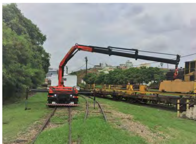
Demonstração de execução de içamento
