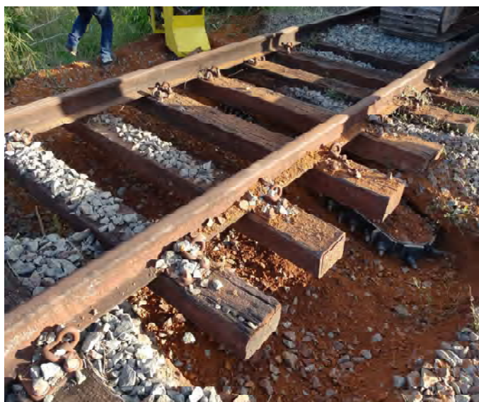
Sabre Desguarnecedor de Lastro em operação, vista superior
