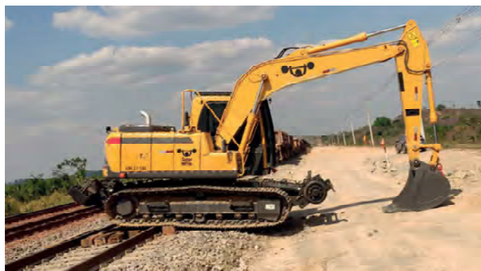
Escavadeira transpondo linha férrea para sair de via
