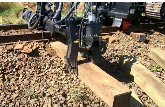
Implemento de Dormentes por Substituição Lateral
