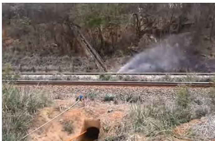
Bueiro desobstruído, após o serviço de limpeza com hidrojateamento
