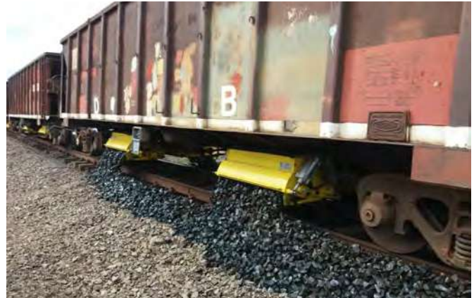
Descarga de lastro em andamento
