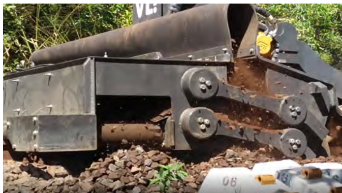
Escarificação do lastro na ferrovia
