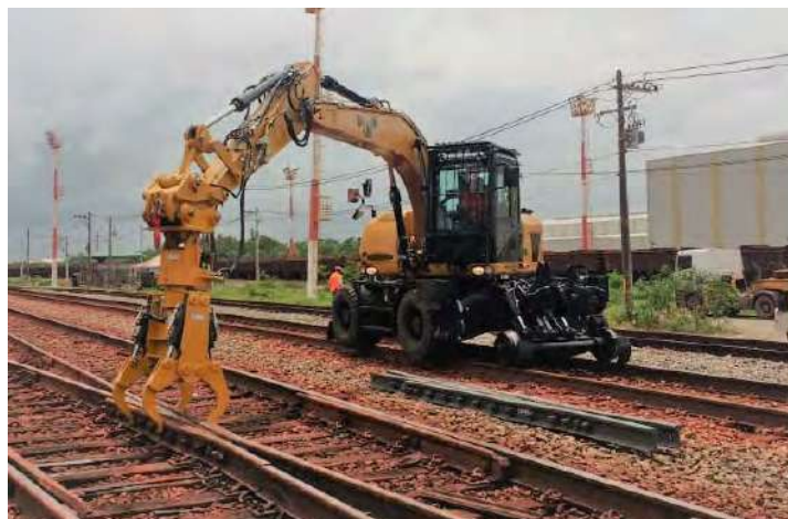
Posicionamento de Jacaré de AMV em linha adjacente
