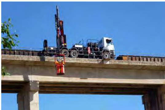
Inspeção em ponte ferroviária
