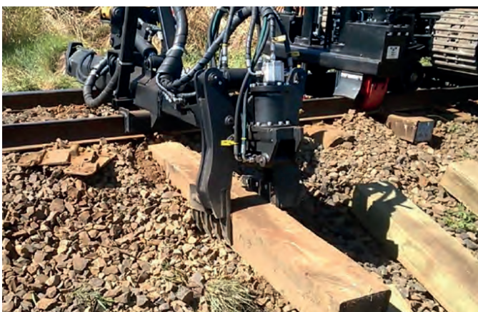
Implemento de Dormentes por Substituição Lateral
