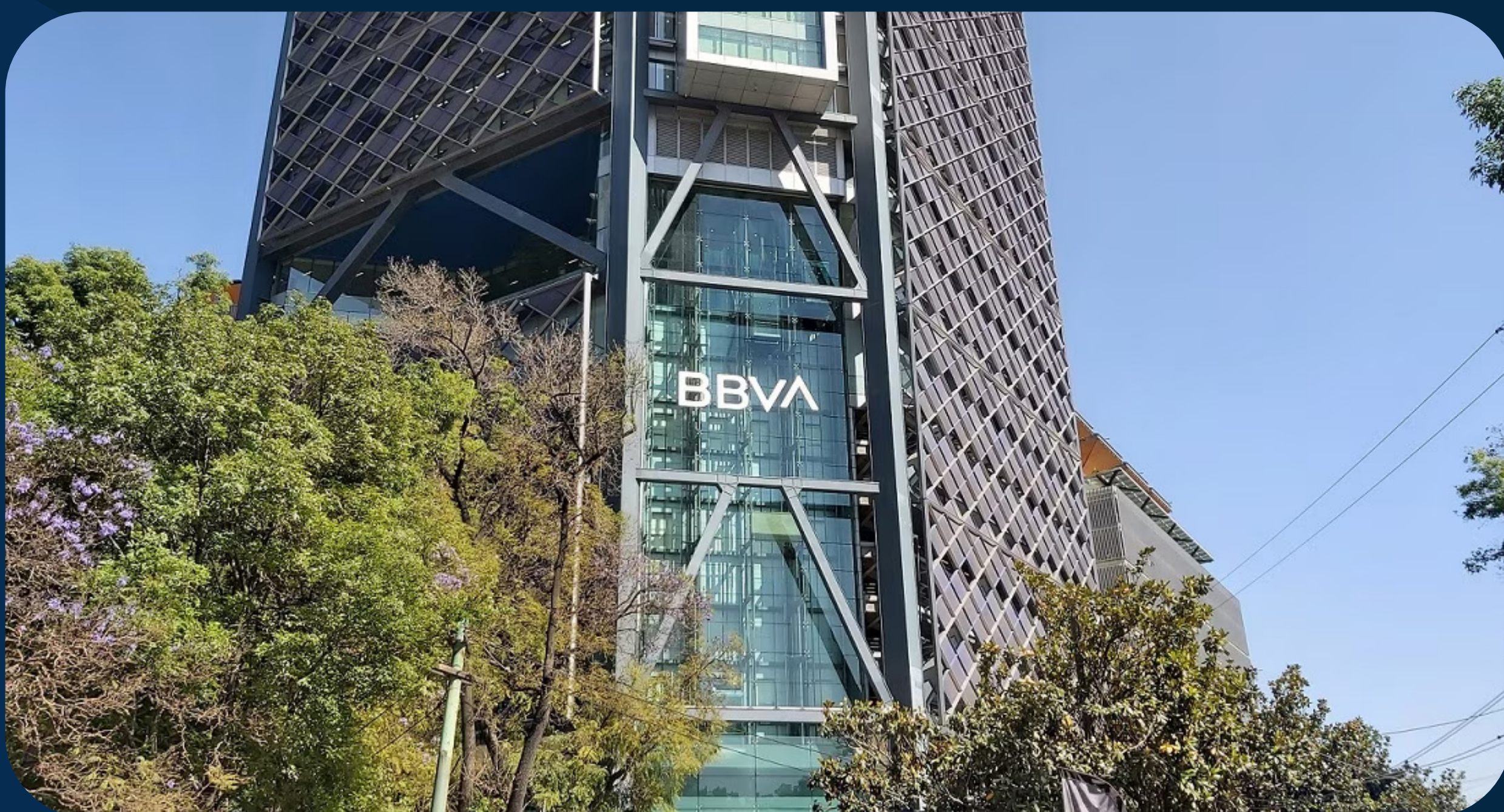
Torre BBVA Cd. de México, QC Inspection.
