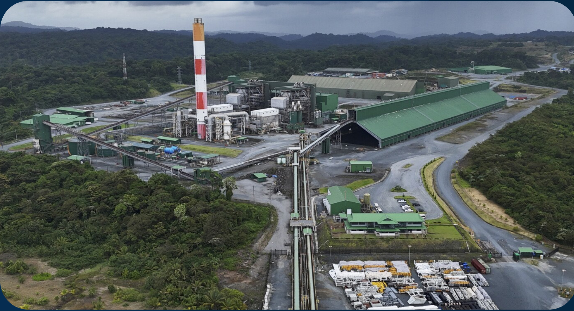
Planta de Energía Panama, Cooper Mine.
