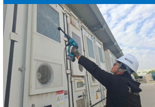
冷卻系統濾網清潔
