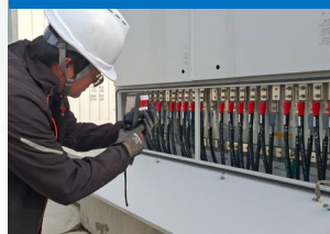
通訊系統線路檢測
