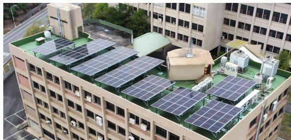
高雄 PV 103.24kWp + ESS 100kW/215kWh + AC Charger 14kW + DC Charger 120kW
