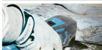
Retirada de alfombras y adhesivo residual TMA018, TMA019
