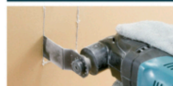
Corte de placas de yeso TMA008-TMA017
