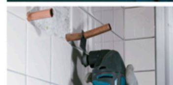
Corte de caños de cobre TMA015, TMA016
