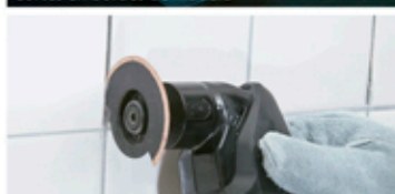
Limpieza de juntas TMA023, TMA024, TMA026
