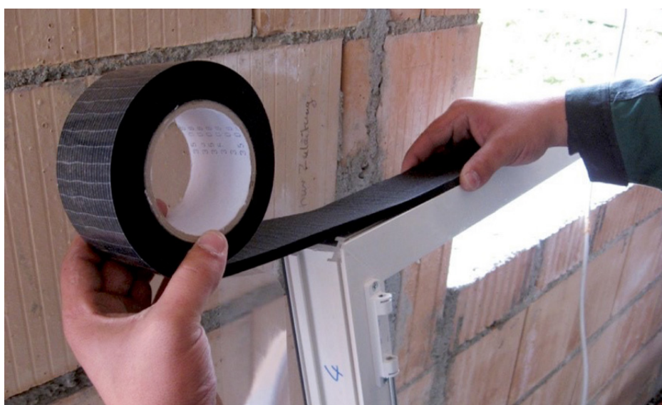
Fig. 7 - Dettaglio di posa del nastro autoespandente
