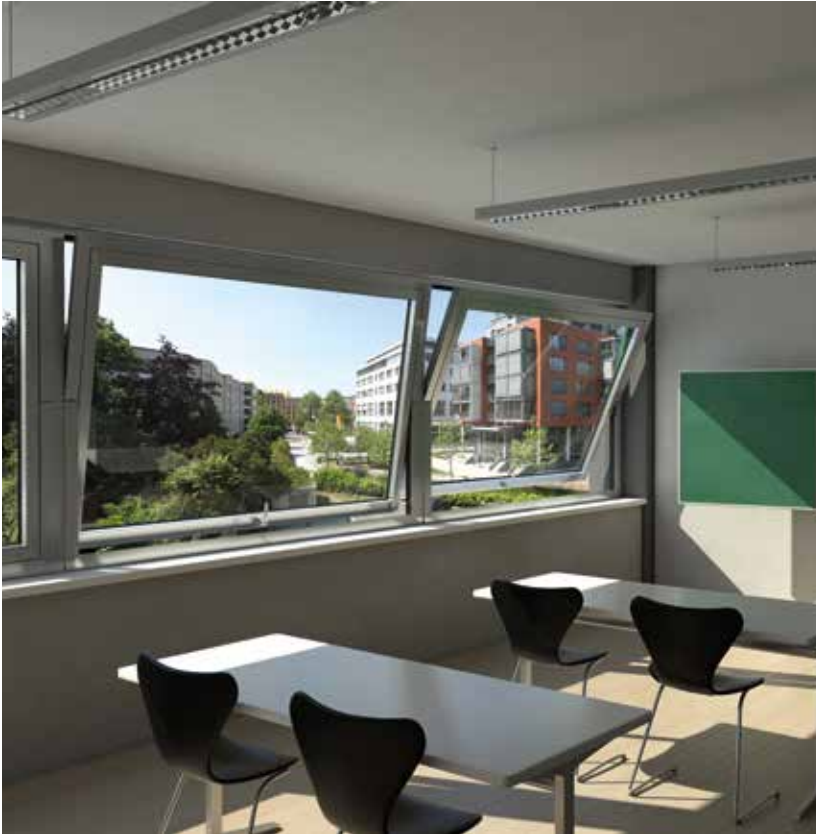
Ante a bilico orizzontale – per una ventilazione ottimale degli ambienti grazie a un elevato ricambio d'aria Horizontal pivot vents – ideal room ventilation thanks to high air exchange rate
