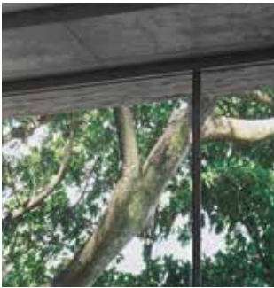
Immagine dettagliata della sezione centrale sottile (opzionale) Detailed illustration of narrow interlocking section (optional)
