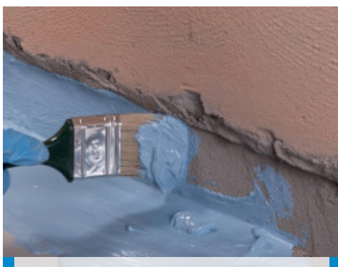
Stesura a pennello di Mapelastich AquaDefense Zero nel raccordo parete-pavimento, prima dell'applicazione di Mapeband
