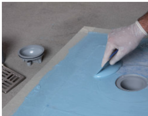
Ammorsamento del tessuto di Drain Vertical con Mapelastich AquaDefense Zero
