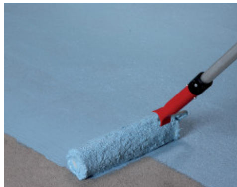
Applicazione della prima mano di Mapelastich AquaDefense Zero su massetto
