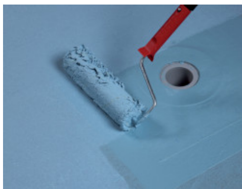
Applicazione a rullo della seconda mano di Mapelastich AquaDefense Zero
