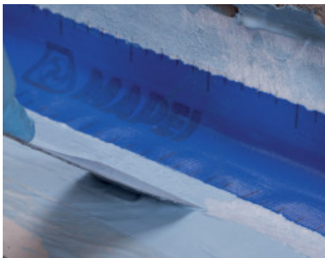
Applicazione di Mapeband nel raccordo parete-pavimento con Mapelastich AquaDefense Zero
