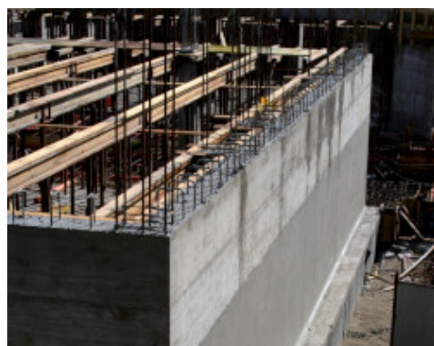
Muro controterra impermeabilizzato in post-getto con Mapelastic Foundation
