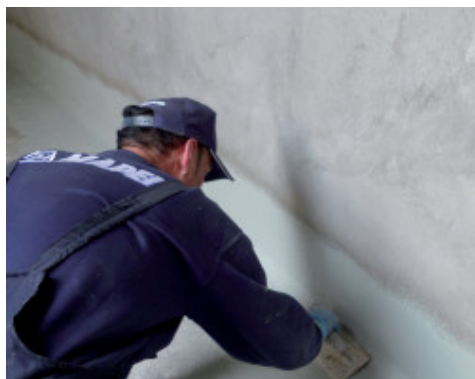
Mapelastic Foundation steso a spatola in un intervento di impermeabilizzazione in controspinta
