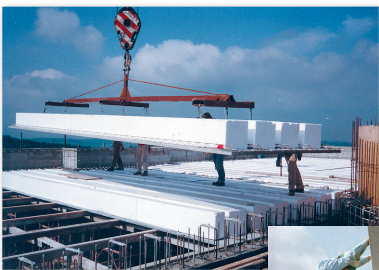
SERBATOIO ACQUEDOTTO DEL PESCHIERA. Monterotondo (RM) Italy
